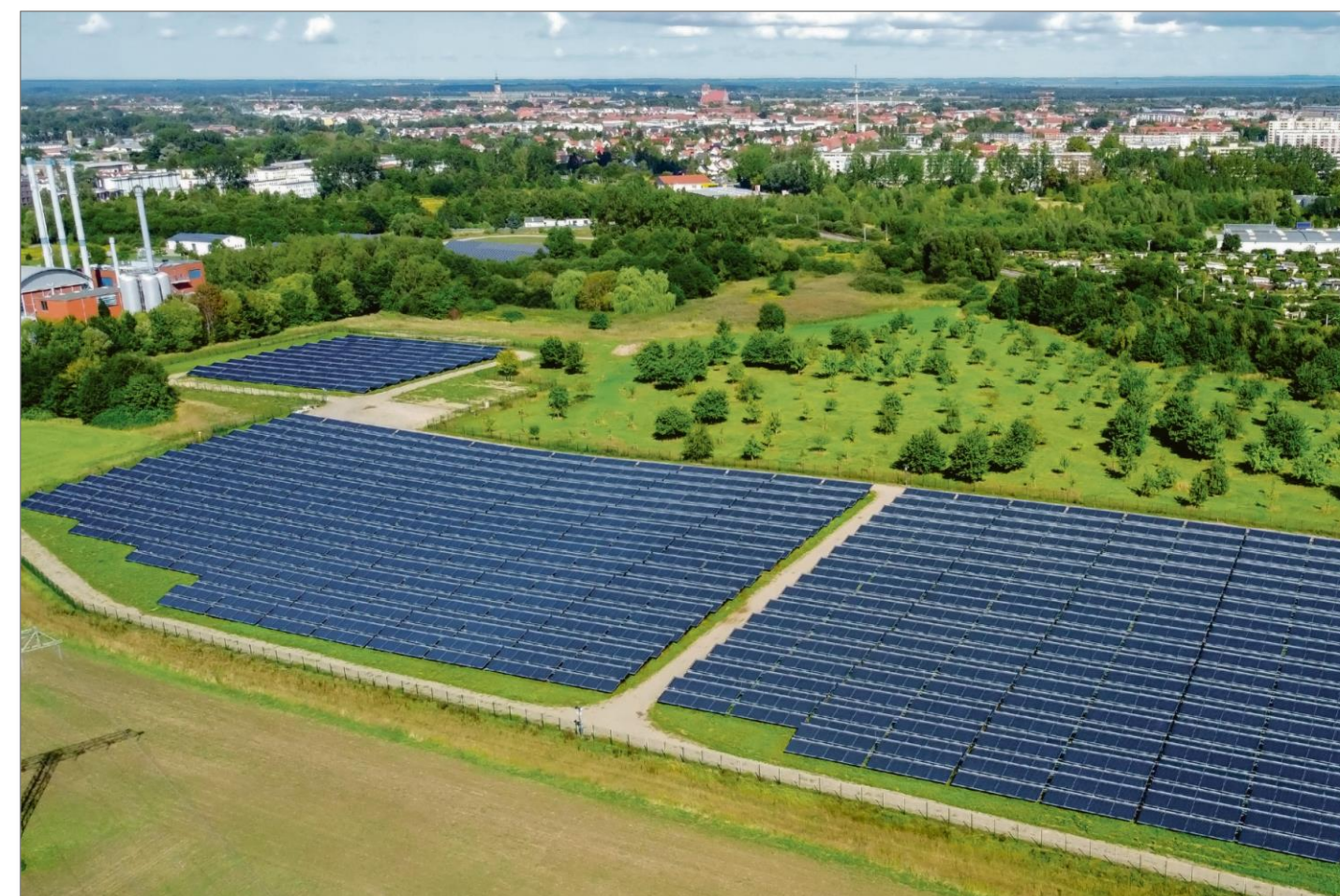
Stadtwerke Greifswald Source: Ritter XL Solar
