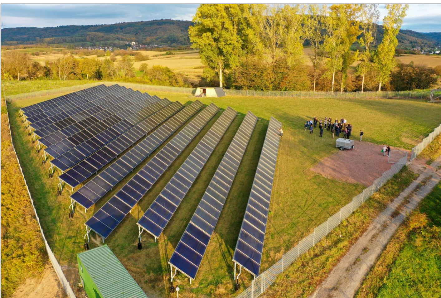
Fernwärme Ettenheim Source: Peter Blaser
