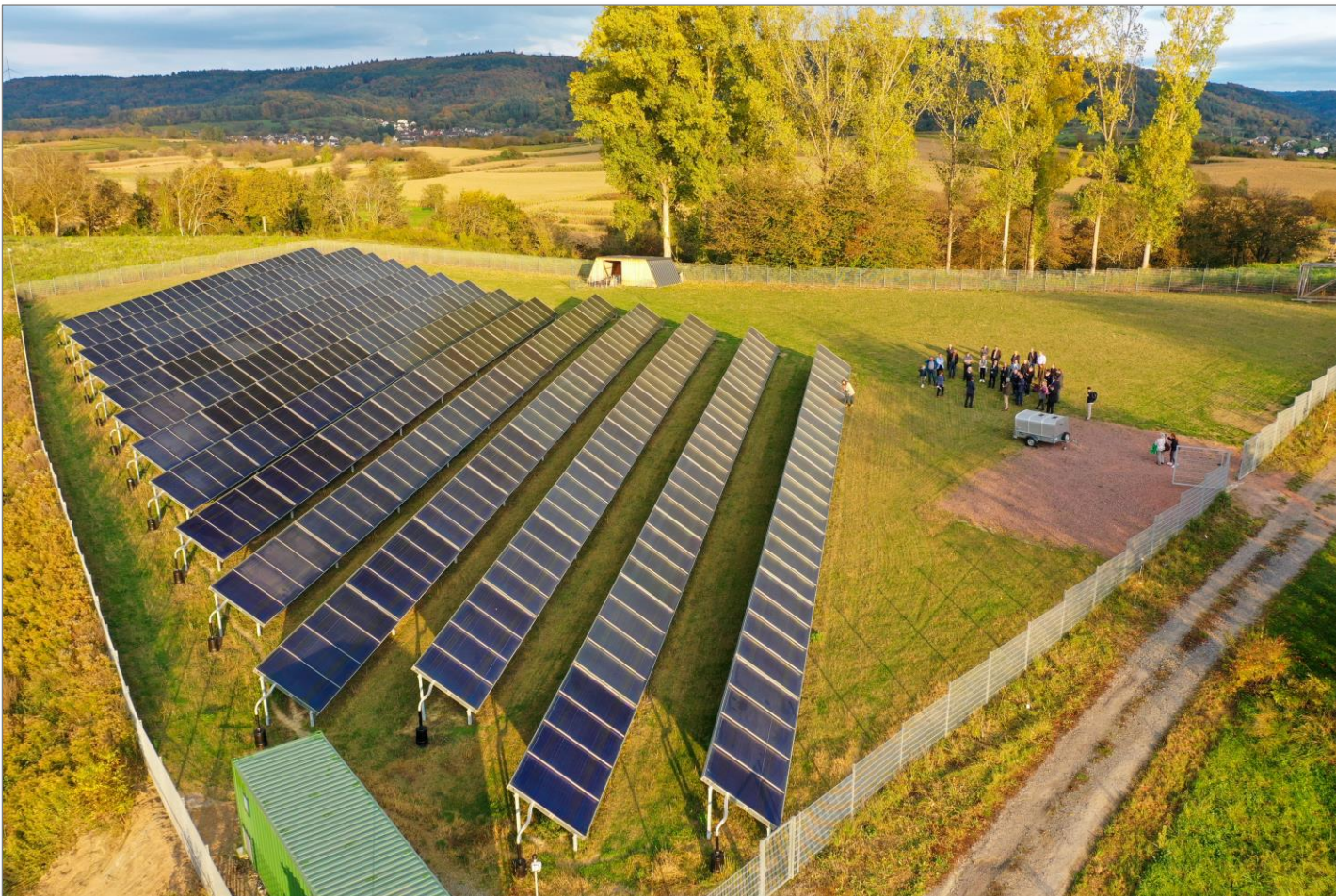
Fernwärme Ettenheim Source: Peter Blaser
