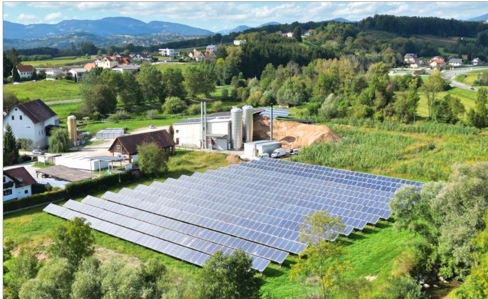
St. Ruprecht an der Raab, Source: Gasokol GmbH
