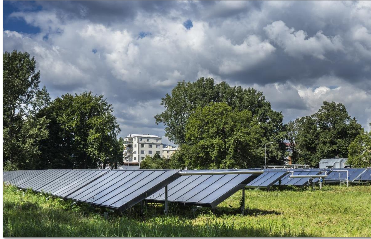
Fernheizwerk Graz (FHW) Source: Picfly.at Thomas Eberhard
